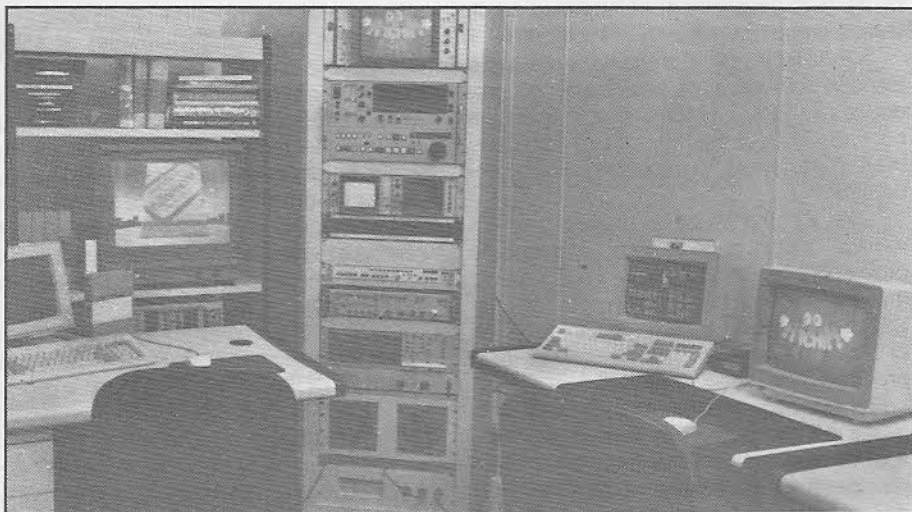
ESTAÇÃO DA GLOBOTEC
